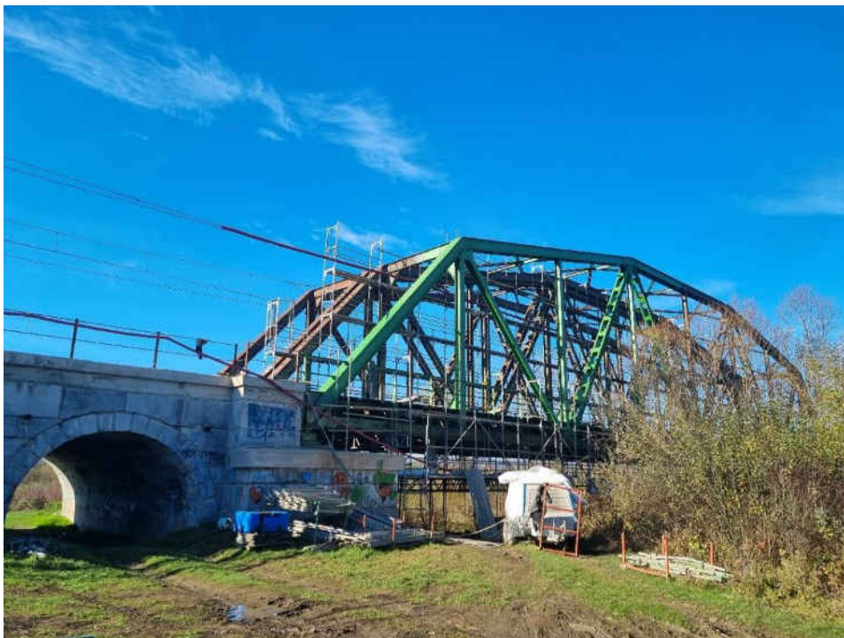
Obnova železniškega mostu ob Murški Soboti.
