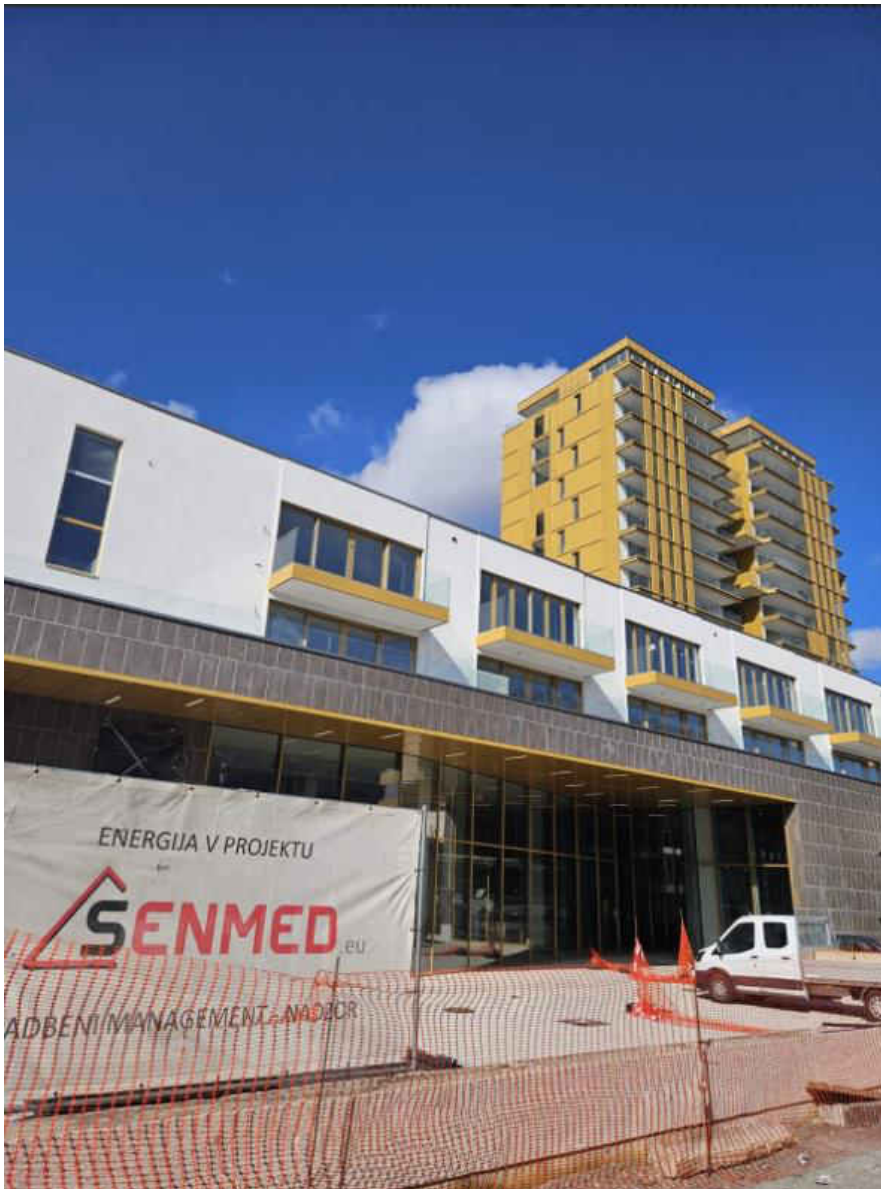
Vzhodno pročelje terasnih hiš z obema stolpnicama v ozadju.
