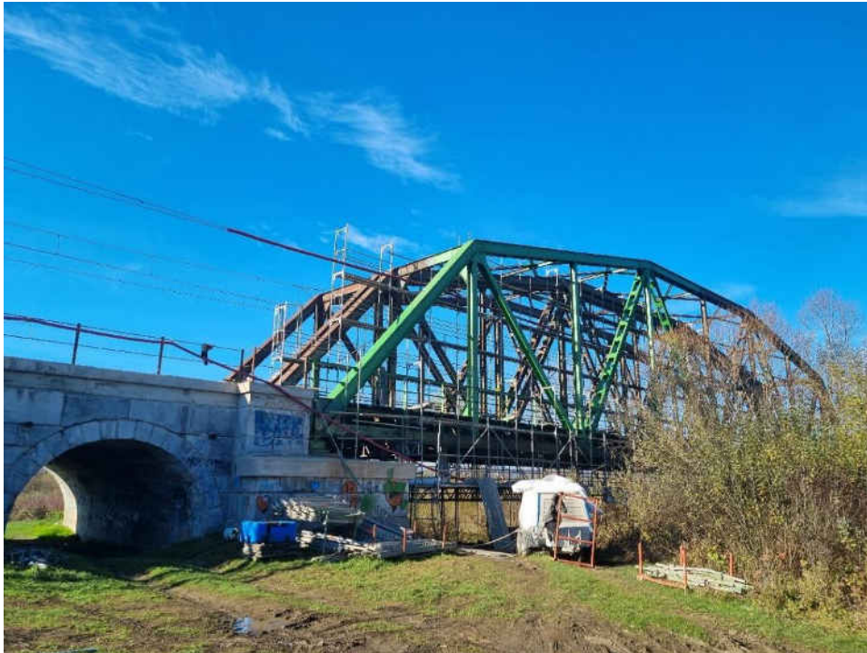
Реконструкција железничког моста код Мурске Соботе.
