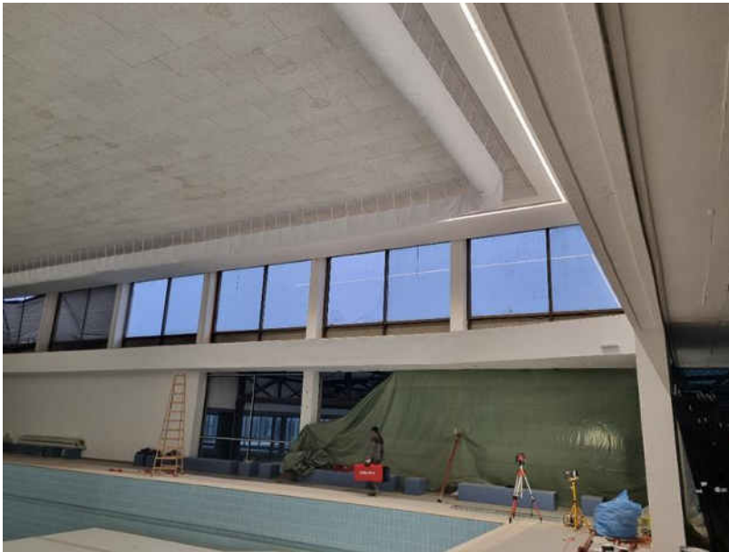
Заштита базена од честица прашине, током извођења радова.
