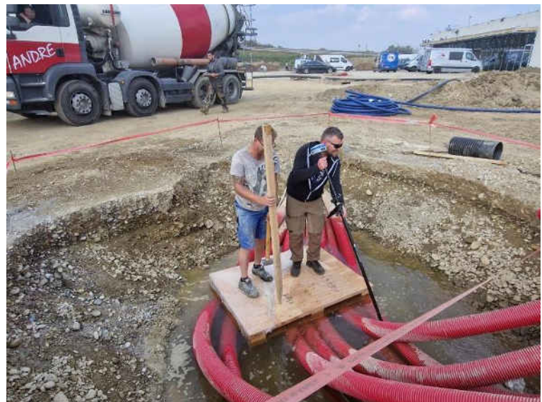
Нивелисање комуникационих инсталација испод кружног тока.
