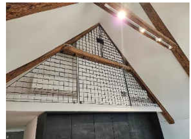
Мрежасте конструкције свуда, у овом случају истовремено штите клима уређаје од механичких оштећења.
