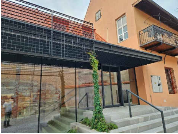
Мрежаста конструкција споља помаже да се прихвате биљке пењачице.
